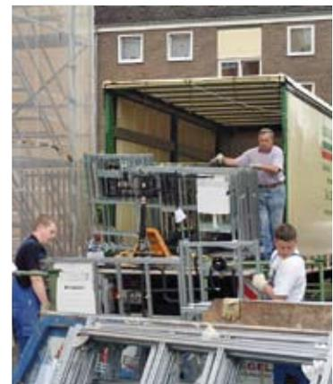
*Vorgefertigte Geberit Sanitärwände werden just-in-time auf die Baustelle geliefert.*
