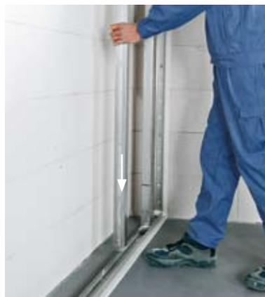
Schritt 2: Systemständer in die Bodenschiene hineinstellen und fixieren.
