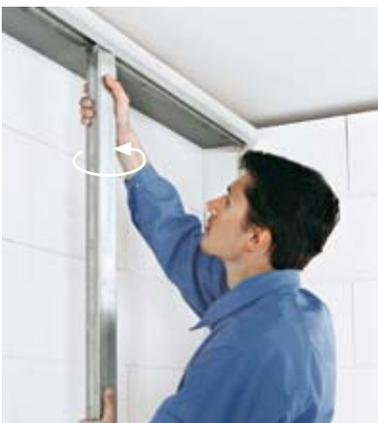
Schritt 1: Systemständer in der Systemschiene eindrehen und Teleskop nach unten ausziehen. Kein Ablängen!
