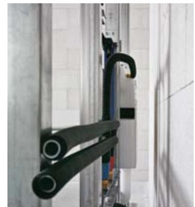
Optimale Schallentkopplung: Geberit Duofix Systemständer und -Element ohne rückwärtige Anbindung.
