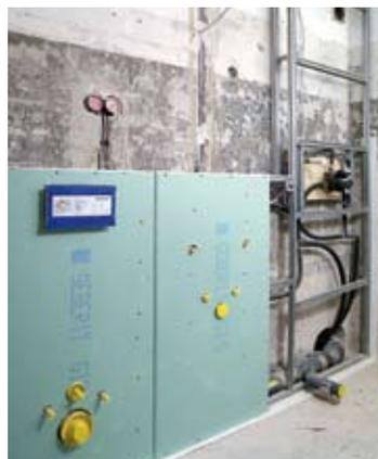
*Die vorgefertigten Sanitärwände müssen nur noch angeschlossen und beplankt werden.*
