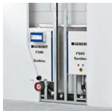
*Sanbloc Wand-WC und Waschtisch, FS90: selbsttragender Installationsbaustein aus mineralischem Porenbeton, nicht brennbar.*
