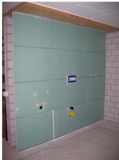
Fig. 225: Installation de paroi en applique Duofix à hauteur du local
